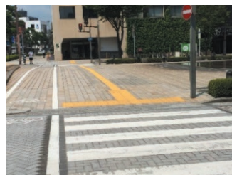
道路の段差の解消や視覚障害者 誘導用ブロックの設置
