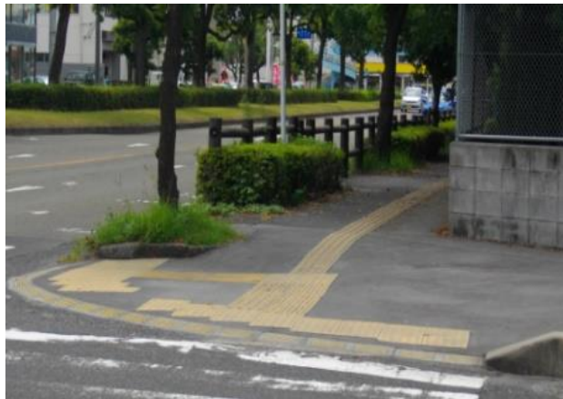
県道 郡元鹿児島港線の整備 (鴨池地区：平成 27 年度整備箇所)
