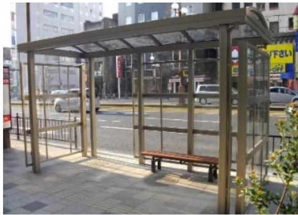
高見馬場バス停留所（中央ビル前）の整備 (中央地区：平成25年度整備箇所)
