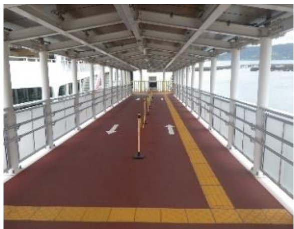
桜島港フェリー乗降施設（人道橋）の整備 (中央地区：令和元年度整備箇所)
