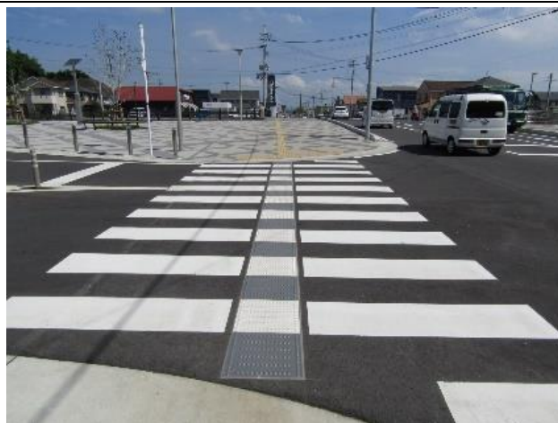
都市計画道路 御所下和田名線の整備 (谷山地区：平成 29 年度整備箇所)
