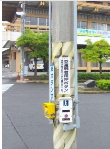
高齢者等感應信号機（武道館前交差点）の設置 （鴨池地区：平成 26 年度整備箇所）
