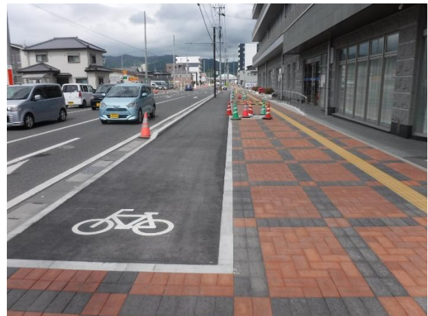
都市計画道路南清見諏訪線の整備
