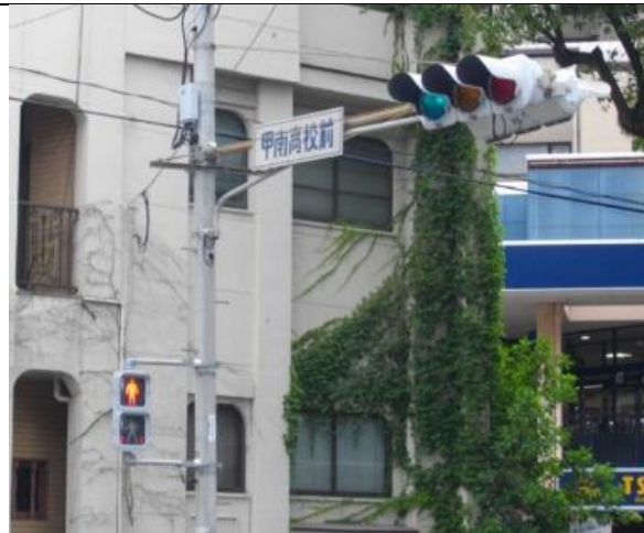
経過時間表示機能付灯器（甲南高校前）の設置 （中央地区：平成 27 年度整備箇所）
