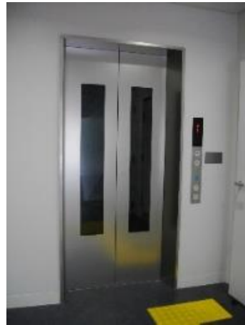
桜島港新フェリーターミナルビルの整備 (中央地区：平成29年度整備箇所)
