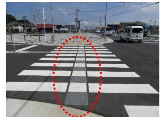
道路を横断する視覚障害者の安全性及び利便性を向上させるために横断歩道上に設置され、視覚障害者が横断時に横断方向の手がかりとする突起体の列
