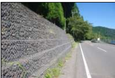
石積みの擁壁
