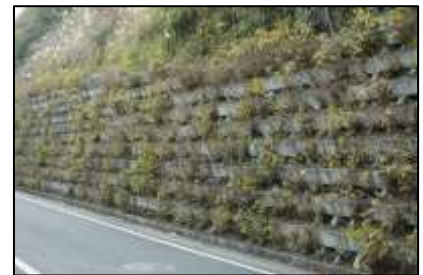
草木による法面の緑化
