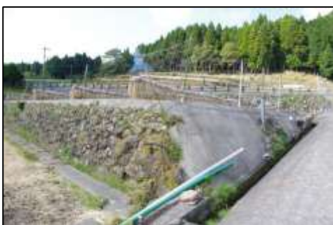
石積みをきちんと残しながら畦畔をコンクリート化している事例。石積みが見えるよう、コンクリート化する場所や方法、仕上がり色彩にも配慮することが大切です。
