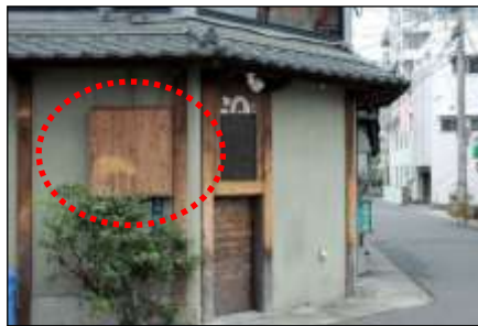
メーターボックスの扉に建物の開口部と調和した素材を用いている
