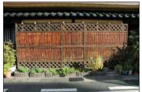
竹矢来で空調室外機を遮へいし、店舗の印象を整えている
