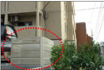
外壁の色彩と調和したルーバーで敷地内の建築設備を囲い、建築設備が目立たないようにしている
