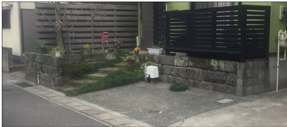
既存の道路沿いの石塀を撤去せずに、敷地内の別の場所で再利用して活用を図っている
