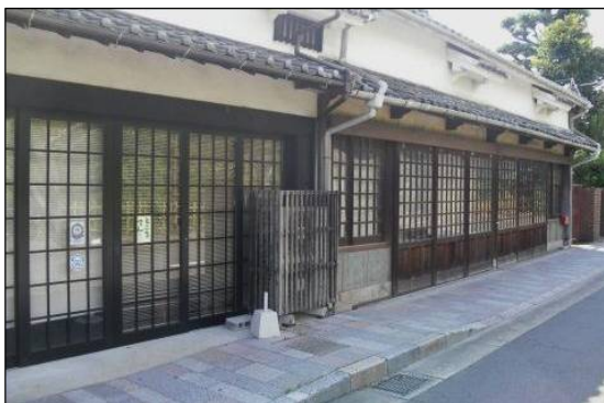
建物の雰囲気に調和した色彩や素材の囲いを設け、統一感を持たせている
