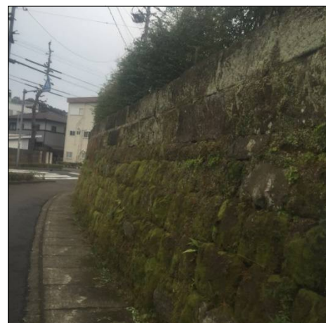
石積みによる擁壁
