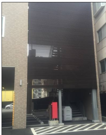
屋外階段を落ち着いた色彩のルーバーで覆い、建物と調和を図るように工夫している
