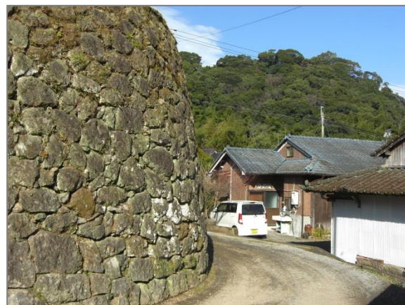
石積みによる擁壁
