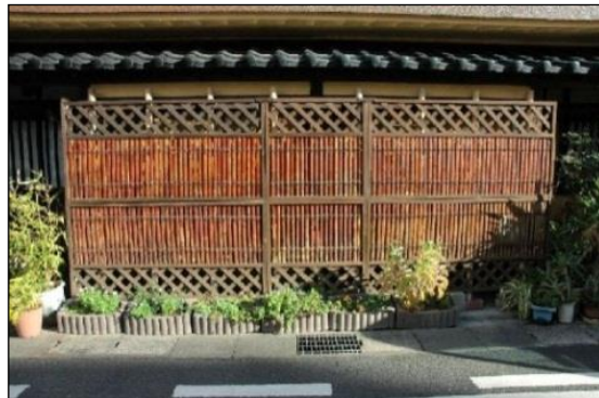
竹矢来で空調室外機を遮へいし、店舗の印象を整えている
