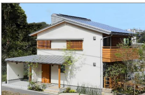
太陽光発電を屋根の色にあわせるとともに、雨樋を壁面の色にあわせている
