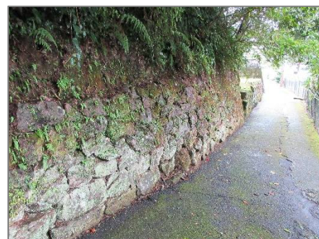
石積みによる擁壁
