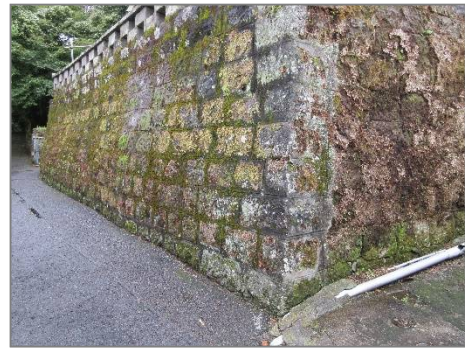
既存の石垣を活用した敷地。
