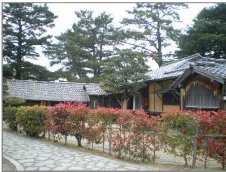
生垣等により周囲の自然景観と調和を図った外構。
