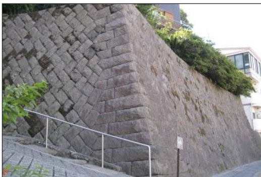
磯街道沿いの石積みによる擁壁
