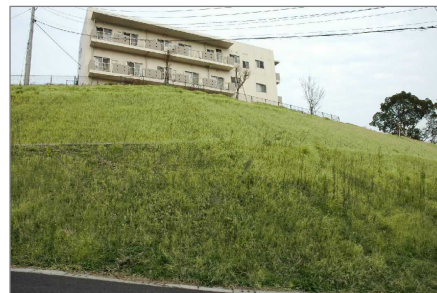
法面を緩やかな勾配にして緑化した例
