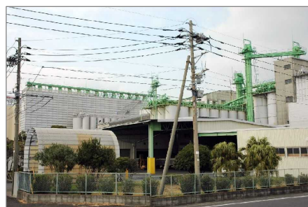
敷地内の複数の工作物の色彩を統一させている
