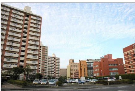
周辺のまち並みと調和した色彩に配慮し、統一感が表れている
