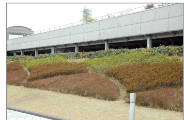
マウンドアップにより駐車場が通りから直接見えないように工夫している
