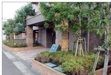
外壁や塀、アプローチ舗装材の色彩を調和させ落ち着いた景観としている
