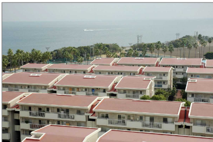
屋根の形態、建物の規模、色彩や素材などが統一され、落ち着いた住宅地を形成している
