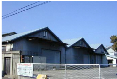
解体された醤油醸造元事務所と醸造蔵
