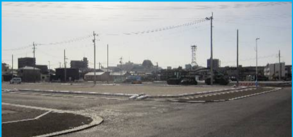
区画道路の工事を進めています。
