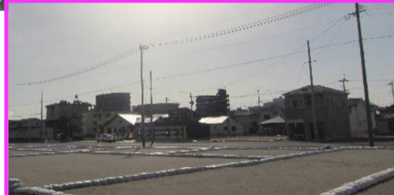
宅地を整備しています。
