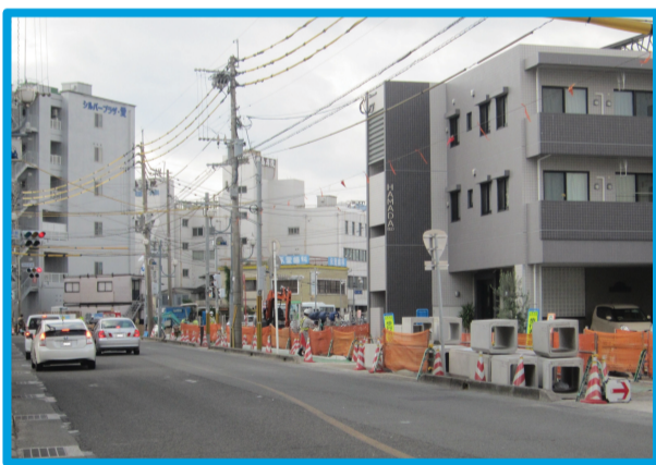
国道225号の整備を進めています。 (平成28年12月撮影)
