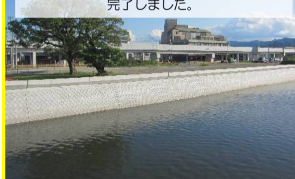
③ 道路擁壁(9・10工区)の工事が完了しました。
