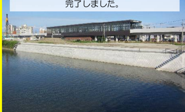
② 道路擁壁(7・8工区)の工事が完了しました。
