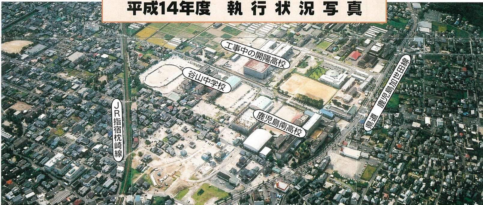
新永田橋付近上空から撮影
