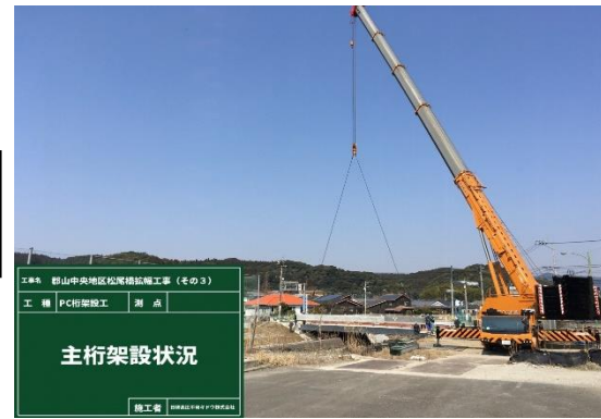
③主桁架設
