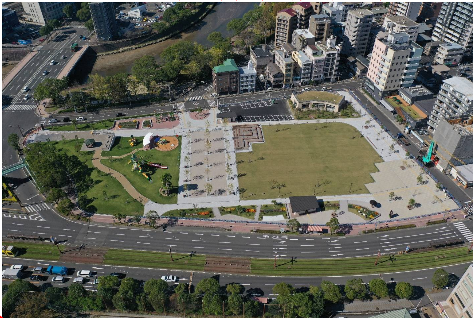
加治屋まちの杜公園（旧称 市立病院跡地緑地）整備
