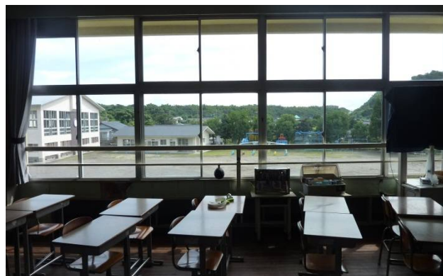
窓ガラス遮熱コーティングを施工した窓(桜洲小学校)
