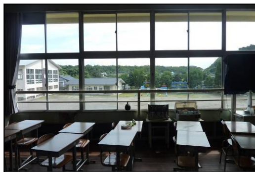
窓ガラス遮熱コーティング
