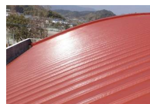
河頭中学校 体育館屋根
