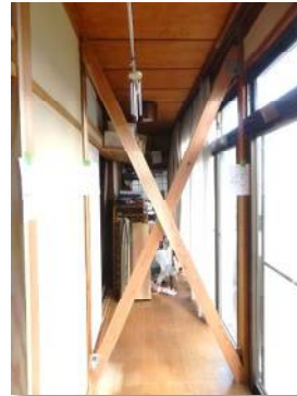
工事中（筋かい入れ状況）
