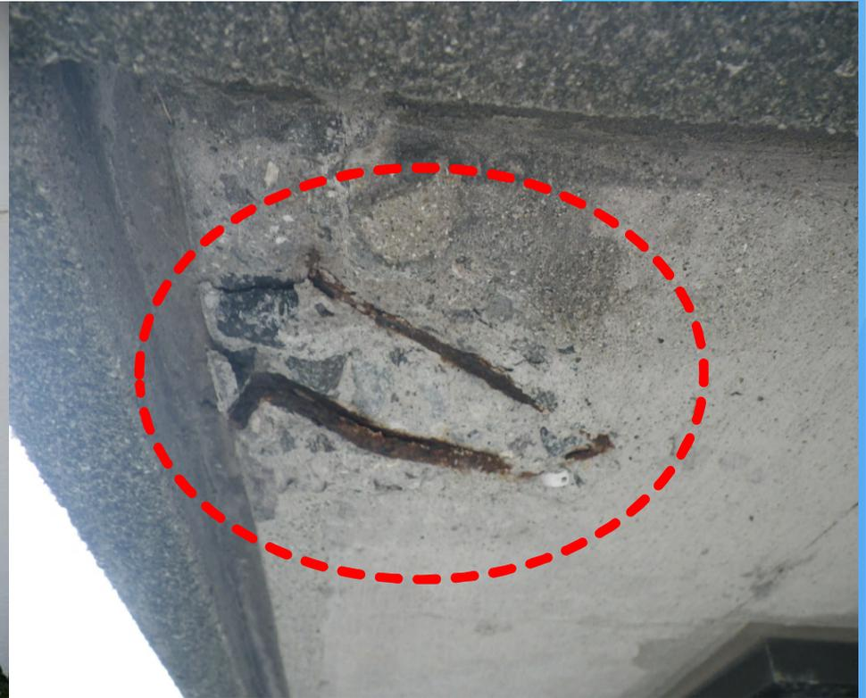
爆裂による鉄筋の露出
