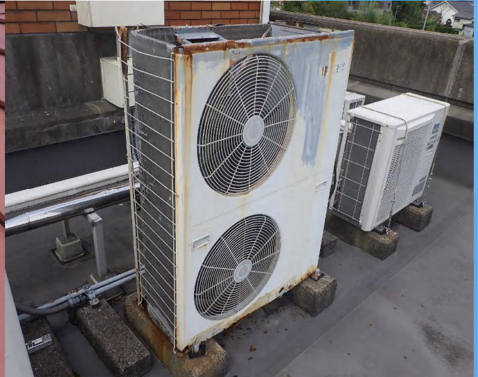
空調室外機の腐食、破損
