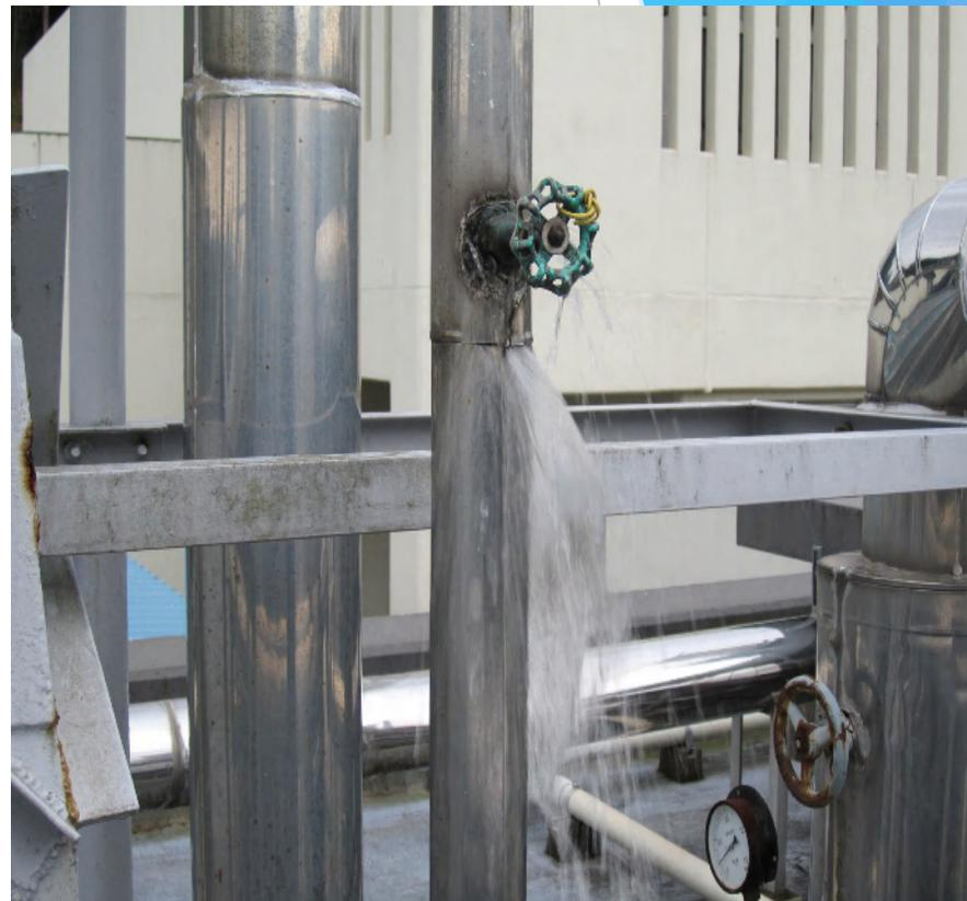
水道配管の破損
