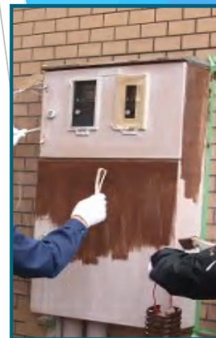
屋外壁面電気ボックス腐食
