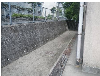
鉄筋コンクリート造
