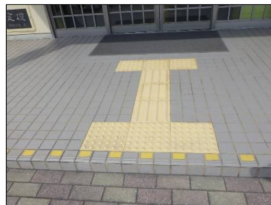
点字ブロック
