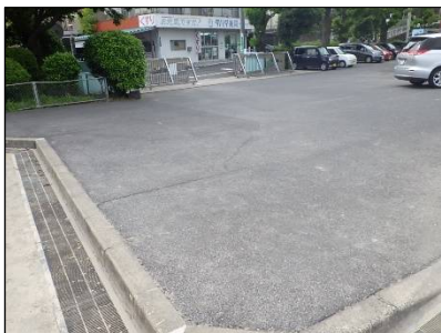
アスファルト舗装
