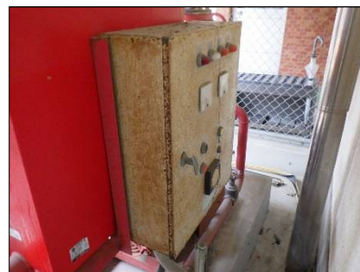
消火ポンプ操作盤の錆
