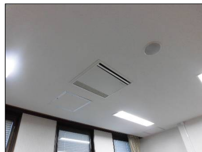
熱交換型換気扇(空調換気扇)
