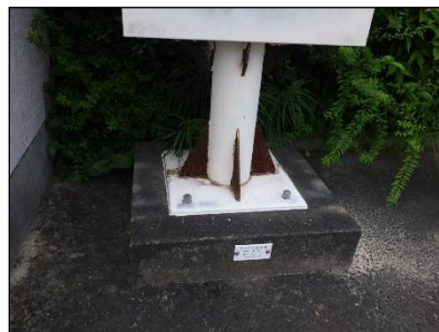
制御盤支柱の腐食
