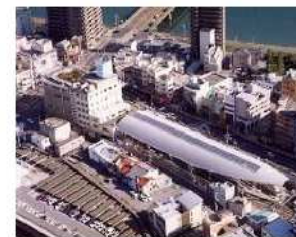
西広島駅（己斐）電停の広場
