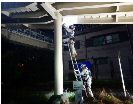
定期点検（近接目視）：梯子点検
