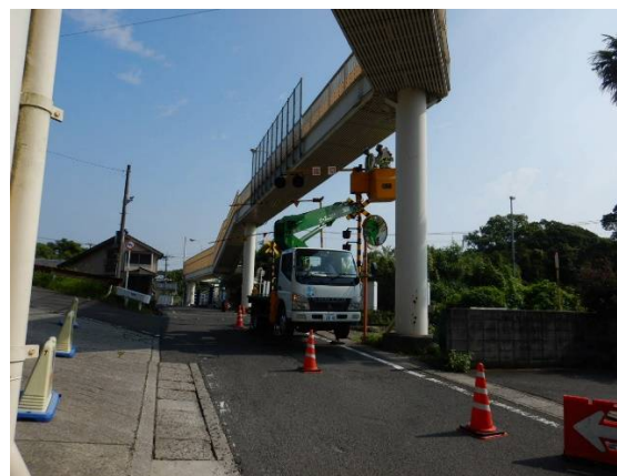
定期点検（近接目視）：高所作業車
