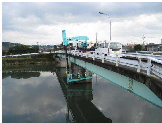
定期点検（近接目視）：橋梁点検車
