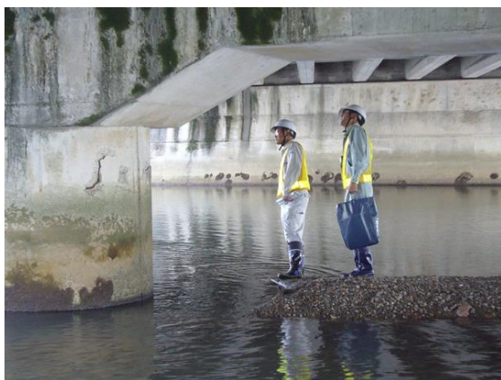
定期点検（近接目視）：徒歩点検
