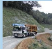
幹線となる道の整備
