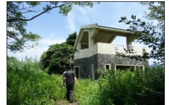
写真4 既存展望施設
