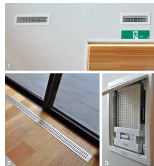
①頭上からの涼風吹き出し口 ②床下からの温風吹き出し口 ③家事動線の高さに設置したフィルターでメンテナンスも簡単
