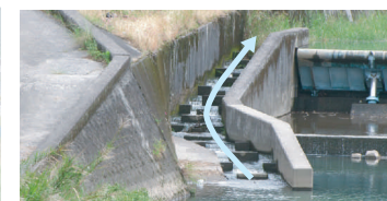
大城戸井堰の魚道
