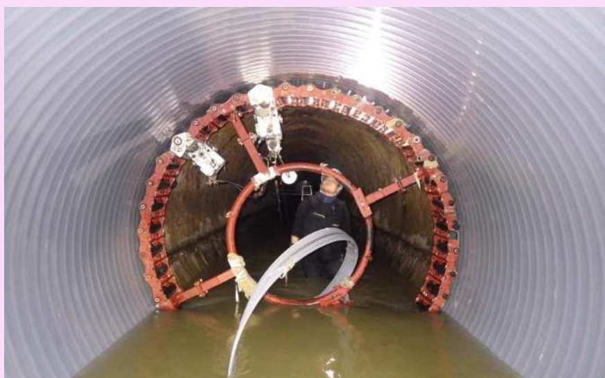
▶ 下水道管の改築
