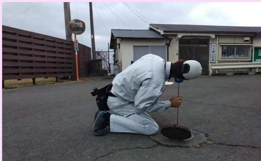
▶ 水道管の漏水調査
