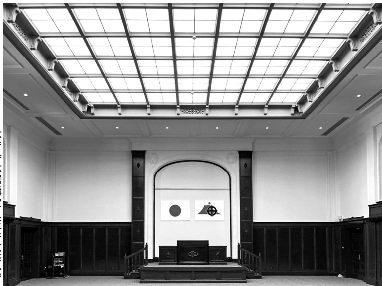
▶本庁舎本館講堂（天井改修後）
