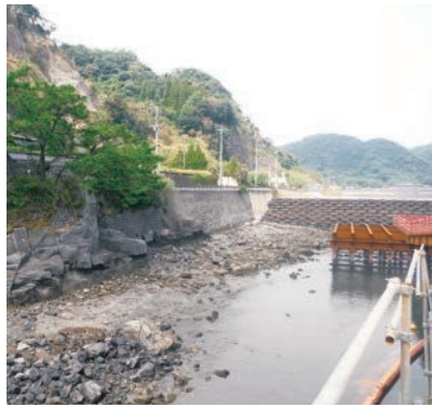
稲荷川の放水路吐口予定箇所
