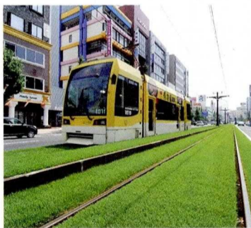
市電軌道敷緑化
