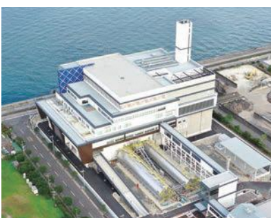
令和4年1月に供用開始予定の新南部清掃工場
