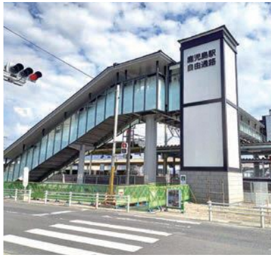
鹿児島駅自由通路の外観
