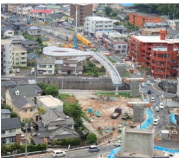
整備が進む高麗通線(郡元一丁目付近)
