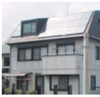
太陽光発電システムを設置した住宅
