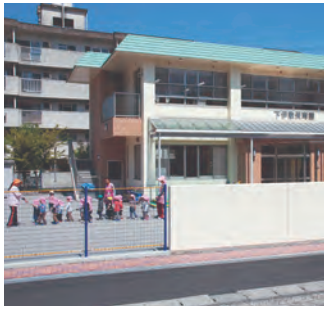
認可保育所の増改築による定員増(下伊敷保育園)
