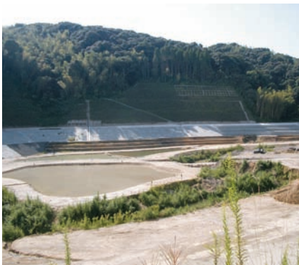
工事中の貯水池底面
