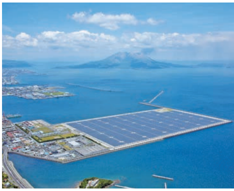
メガソーラー発電所
