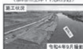
施工状況 令和4年9月撮影 ⑫ 水戸市中野内地区 （那珂川左岸14.5k付近）
