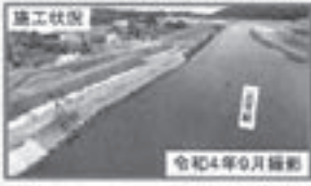
施工状況 令和4年9月撮影 ⑭ 常陸大宮市野口地区 （那珂川左岸40.5k付近）
