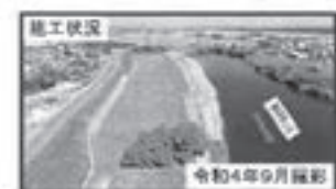
施工状況 令和4年9月撮影 ⑪ 水戸市根本地区 （那珂川右岸13.5k付近）
