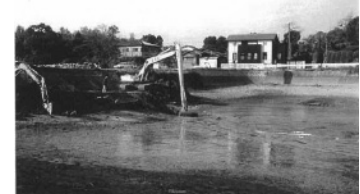
<ため池の浚渫工事(イメージ)>
