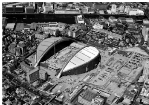
第1期工事（遠方より） （出典：ノエビアスタジアム神戸HP）
