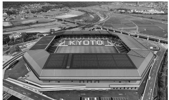
スタジアムの屋根に搭載されている太陽光パネル（出典：サンガスタジアムHP）
