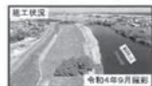
施工状況 令和4年9月撮影 ④ 水戸市根本地区 （那珂川右岸13.5k付近）
