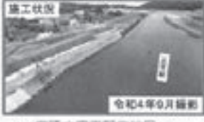
施工状況 令和4年9月撮影 ⑧ 常陸大宮市野口地区 （那珂川左岸40.5k付近）
