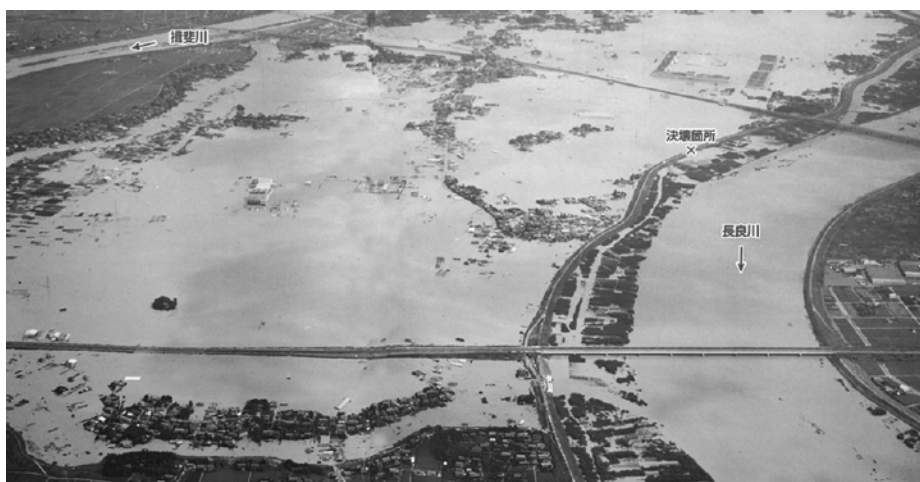
長良川右岸、大森地先の堤防決壊による浸水状況（岐阜県安八郡安八町・大垣市墨俣町）
