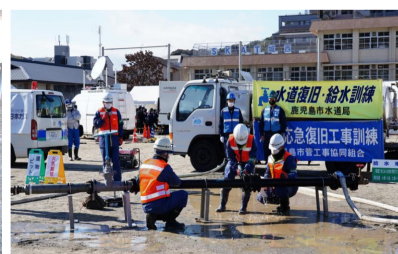
水道復旧工事訓練
