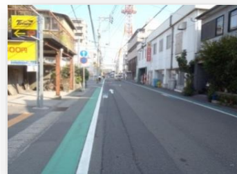
路側帯の設置・拡幅 カラー舗装
